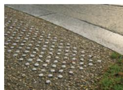
CLOU, PLOT ET DALLE PODOTACTILES
